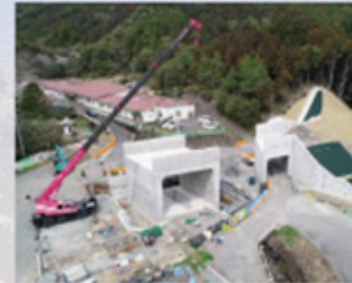
施工中（清水地区）
