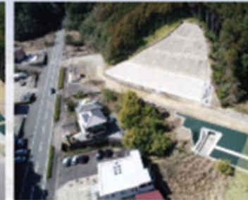
施工後（大谷地区）
